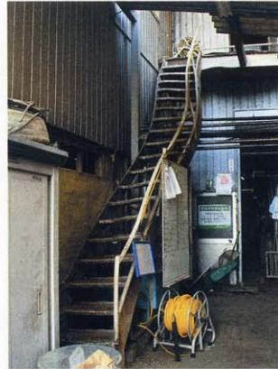
火事のとき、階下に置いてあったガスボンベが爆発し階段が曲がってしまった。火事の教訓としてそのまま置いている
