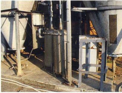
水は井戸水を使用し、上澄みを使っている。水タンクの横にある小さなタンクは腐植剤（ペレット）が入っており、徐々に溶け出る仕組み
